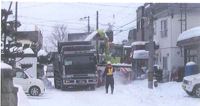
道幅の狭い生活道路の除排雪
