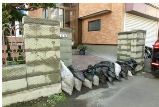
大雨の天気予報が出ると、水の流入を防止する土嚢を積んでいる。 (北郷5条3丁目住宅)
