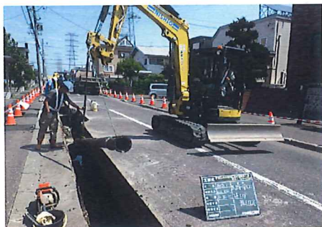
6、切替完了後、使用しなくなった古い管を撤去していきます。
