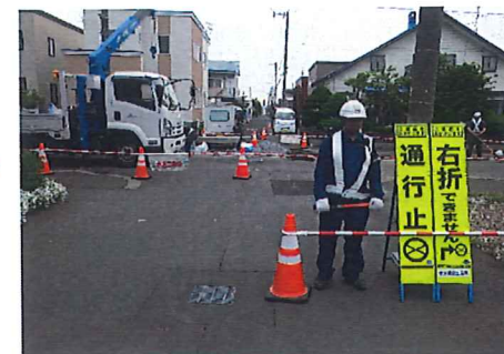
3、工事は基本的に掘削作業なので歩道迂回での作業となります。(事前にチラシを配ります)
